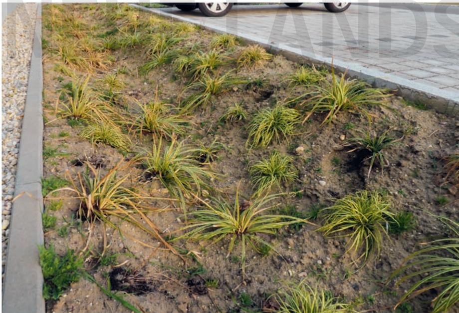
**Mühsamer Versuch.** Eine Staudenpflanzung in einer Regenwasserversickerungsmulde mit dem vorgeschriebenen Oberboden. Man sieht schon das Unkraut aus dem Oberboden sprießen, das wird eine pflegerische Dauerbaustelle. Die nächste Frage: Warum nur eine Art – und dann auch noch eine panaschierte Japansegge? Das kann doch nur schiefgehen. Nicht heimische Sorten
