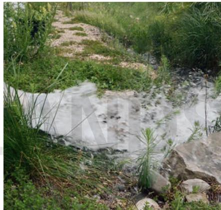
**Starkregenereignisse.** Wir brauchen neue Wege für das Regenwasser. Hier leitet die Regenrinne bei einem Starkregen das Wasser von 1000 m<sup>2</sup> Gebäudedach direkt in einen der 150 m langen Regenwasserversickerungsgräben, die einmal rund ums Gebäude führen. So ist es bei Skywalk in Marquartstein.
