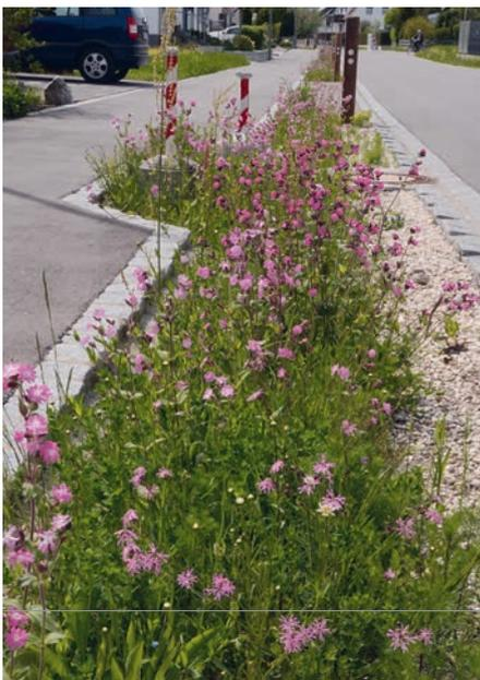
**Naturnahe Regenwasserversickerung im 2. und 3. Jahr. In einer kleinen Allgäuer Gemeinde wurden die nur meterbreiten Streifen, wie in im Rezept beschrieben, mit einer Deckschicht aus Kalkschotter 0/32 mm gebaut. Konsequenz ohne**
