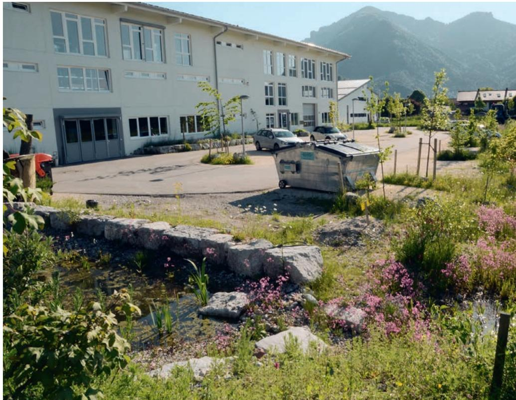
**Skywalk in Marquartstein. Ein Paradebeispiel des neuen Umgangs mit Regenwasser. Alles Dachwasser von 1000 m<sup>2</sup> Dächern und allen Verkehrswegen auf dem Gelände wird konsequent in 150 m langen Regenwasserversickerungsgräben geleitet, gereinigt und langsam ans Grundwasser abgegeben. Dazwischen blüht, wächst und wim-**
